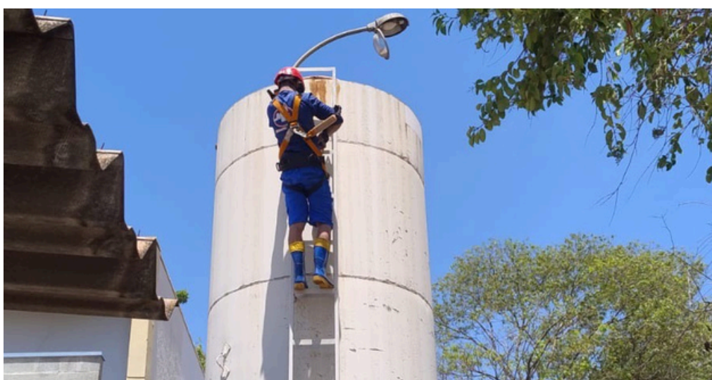
Limpeza e desinfecção dos reservatórios
